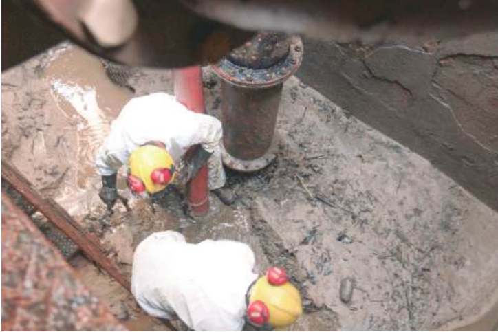
Equipes na limpeza da Estação de captação do Semae
