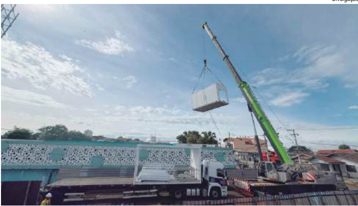
Módulos começaram a ser instalados no Hospital Municipal
