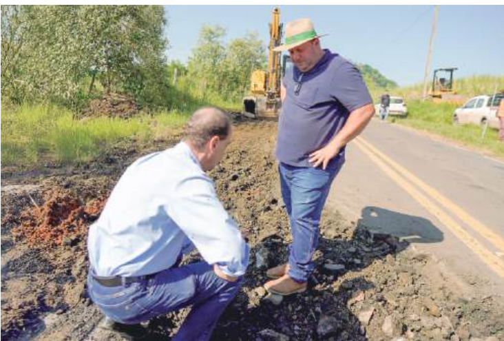
Enquanto a obra é preparada, equipes realizam reparos emergenciais
