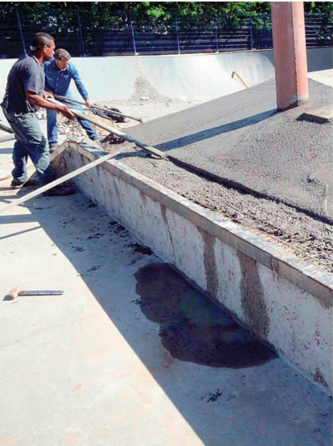
Na terça-feira, 20, foi realizada a concretagem dos obstáculos e caixotes
