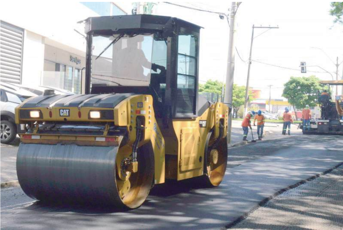
Aplicação da nova massa asfáltica ocorre após a conclusão dos serviços de fresagem
