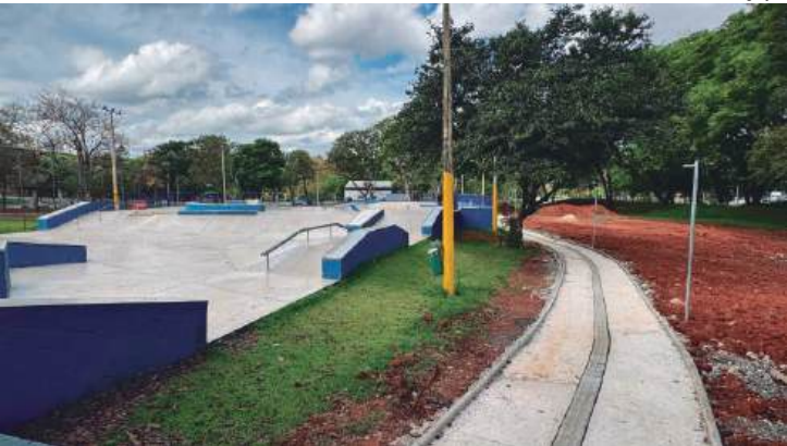
Pista de caminhada segue em construção
