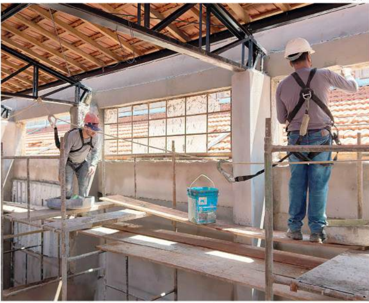
Estão sendo feitos os revestimentos das paredes
