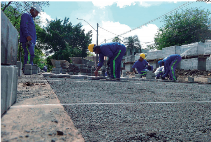
Assentamento de blocos de concretos são encaixados manualmente
