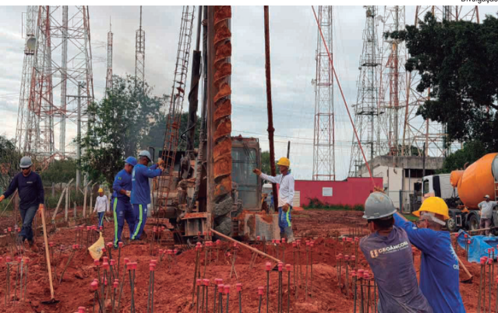
Após abertura do buraco é feito estaqueamento com estrutura de aço e inserção de concreto de secagem rápida
