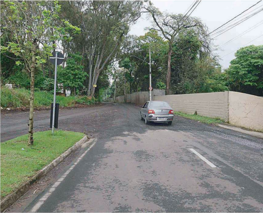
Avenida das Ondas será pavimentada em toda sua extensão
