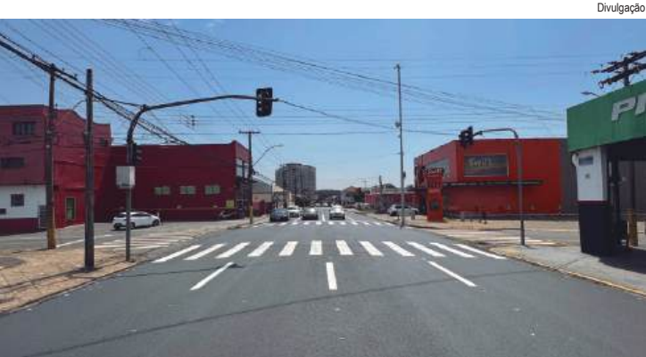
Avenida Dona Francisca, na Vila Rezende, ganha novo pavimento
