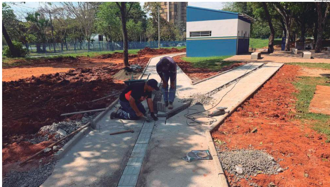
Pista de caminhada está sendo construída e percorrerá toda área do espaço esportivo.
