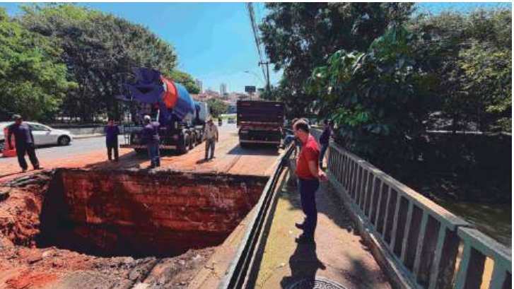
Os serviços estão sendo realizados por meio da Secretaria Municipal de Obras, Infraestrutura e Serviços Públicos
