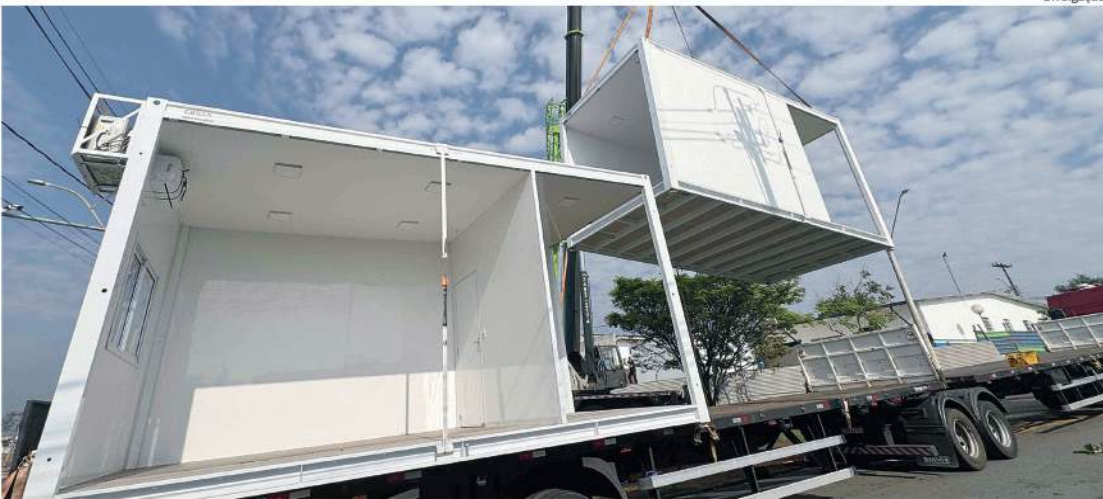
Os 16 módulos começaram a ser instalados ontem, 25, na Unidade do Parque Piracicaba
