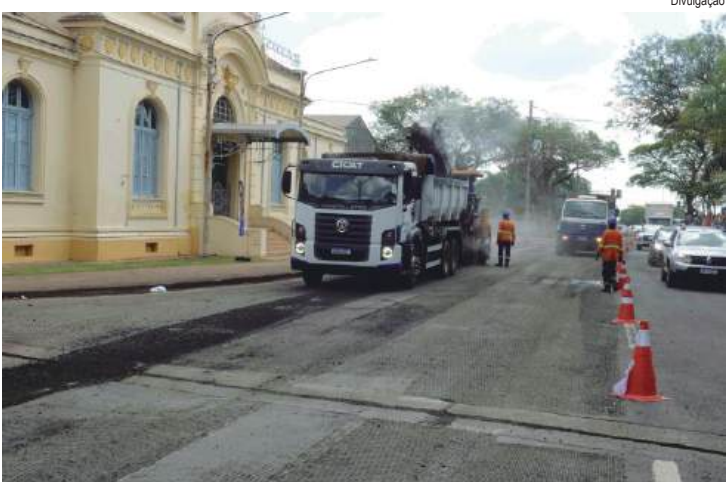
Avenida Dr. Paulo será contemplada no trecho entre a rua do Rosário e o viaduto da avenida 31 de Março
