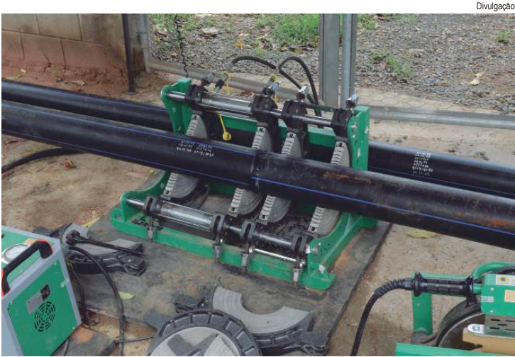
Equipamento de termofusão faz a conexão das novas tubulações
