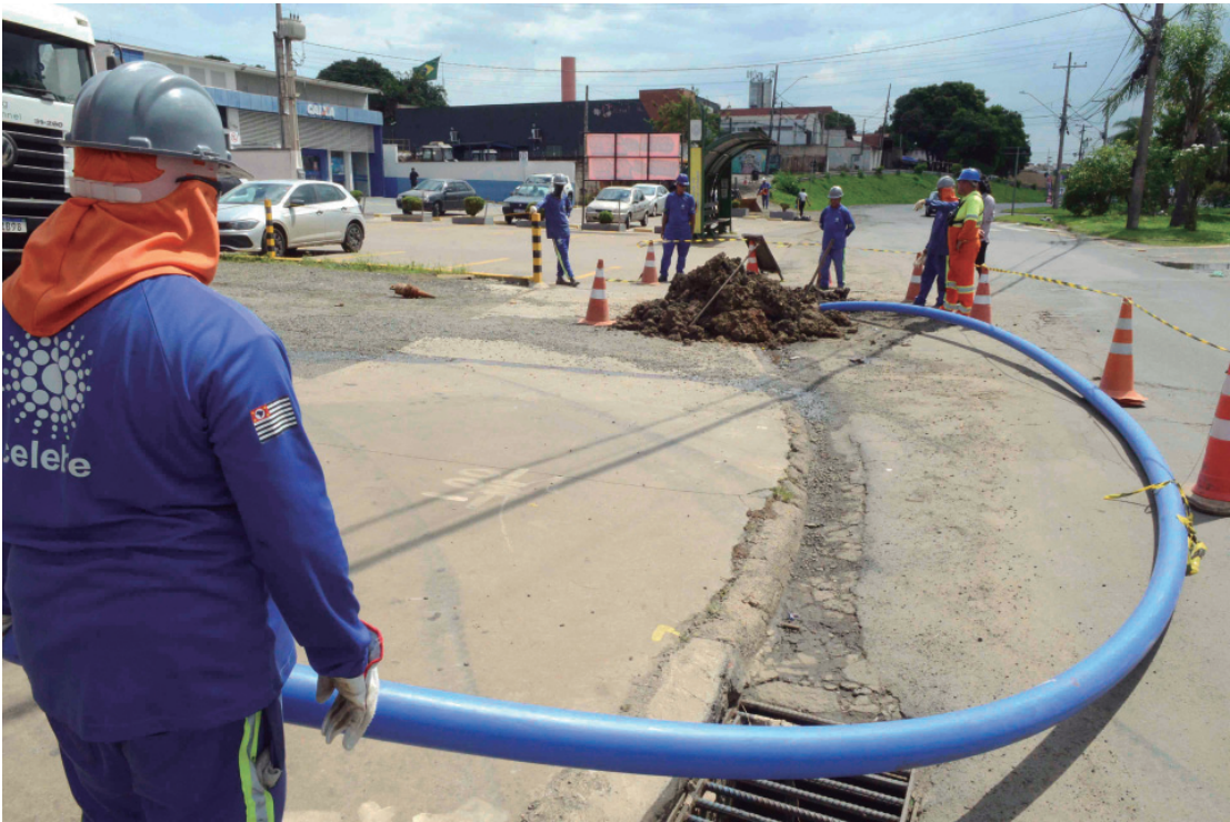
Obra de troca de tubulação da rede de água; um dos destaques entre os ODSs avaliados é Água e Saneamento
