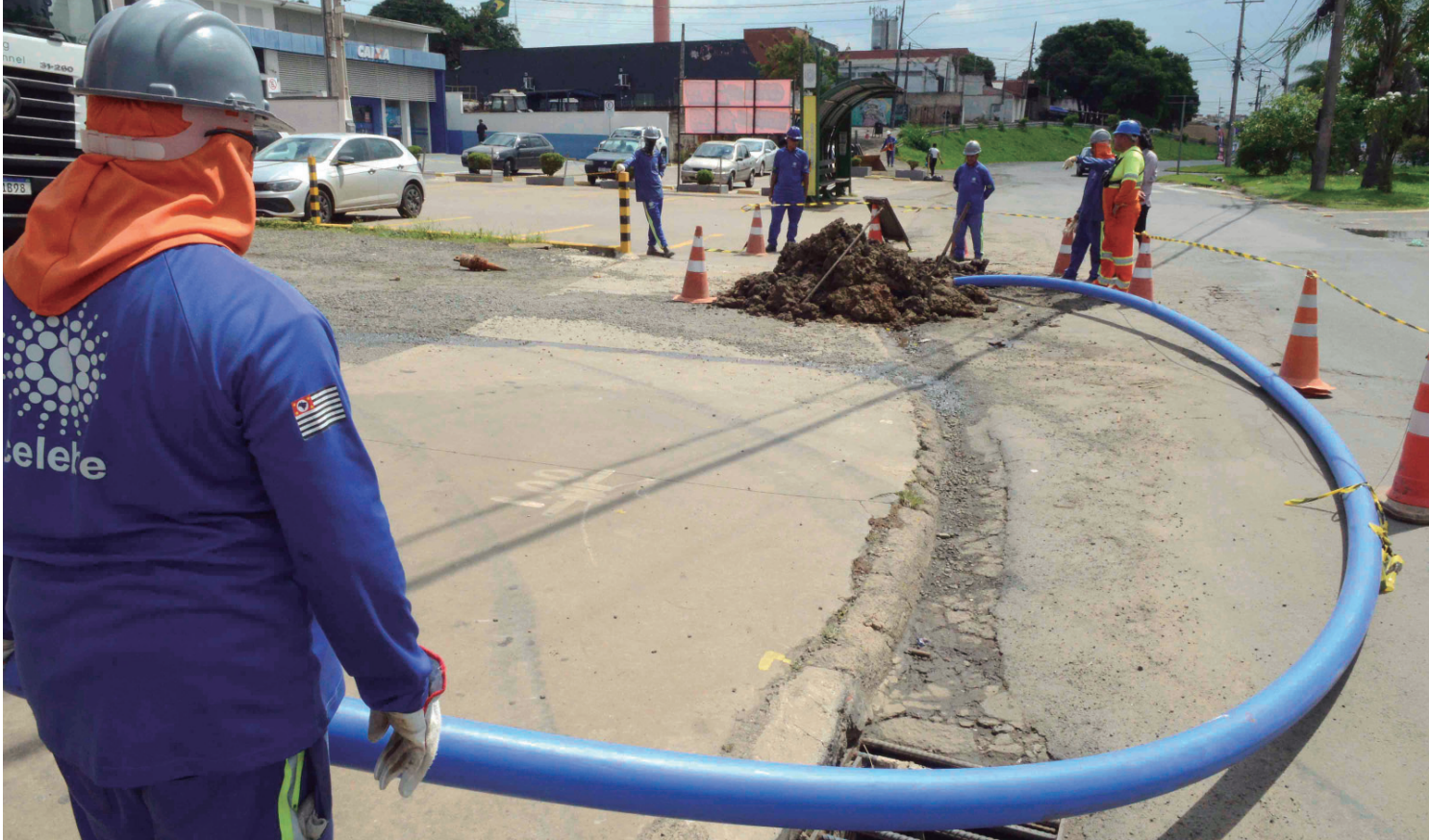
Obra de troca de tubulação da rede de água, um dos destaques entre os ODSs avaliados é Água e Saneamento
