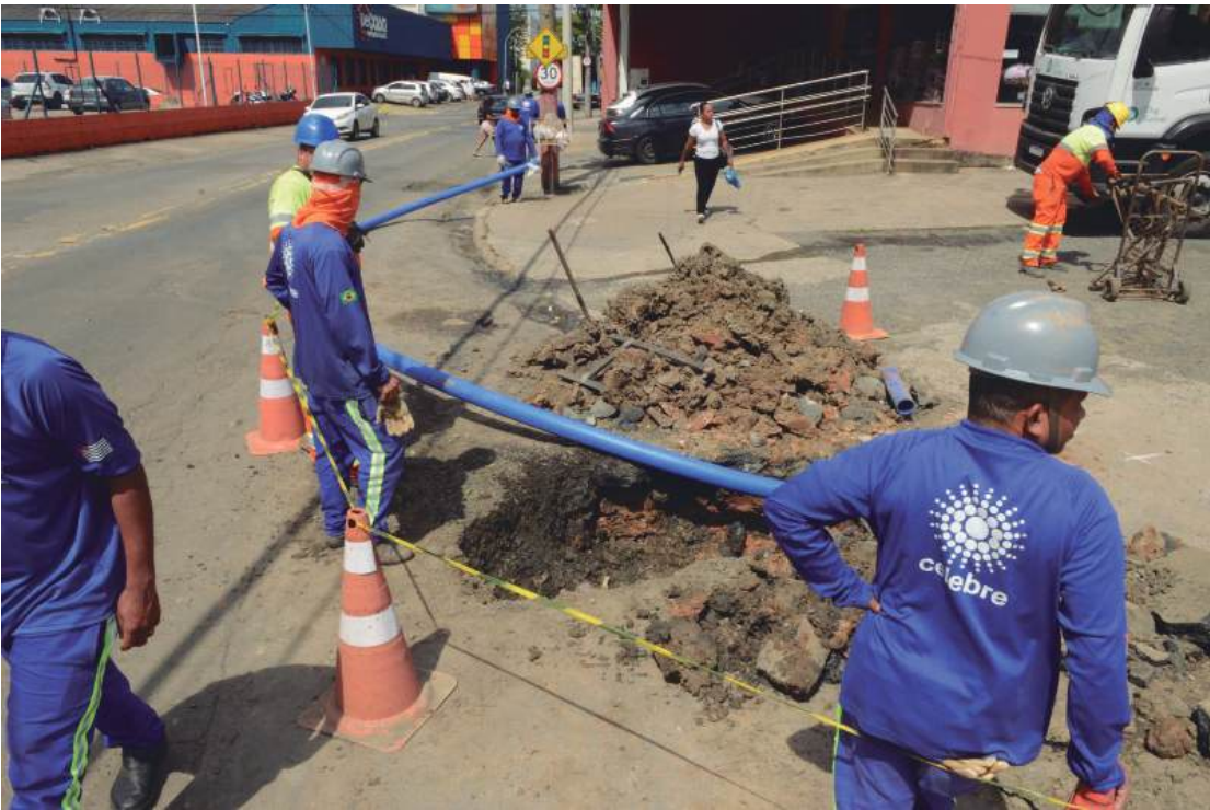
Obra do Sema e deve beneficiar mais de 80 mil pessoas da região
