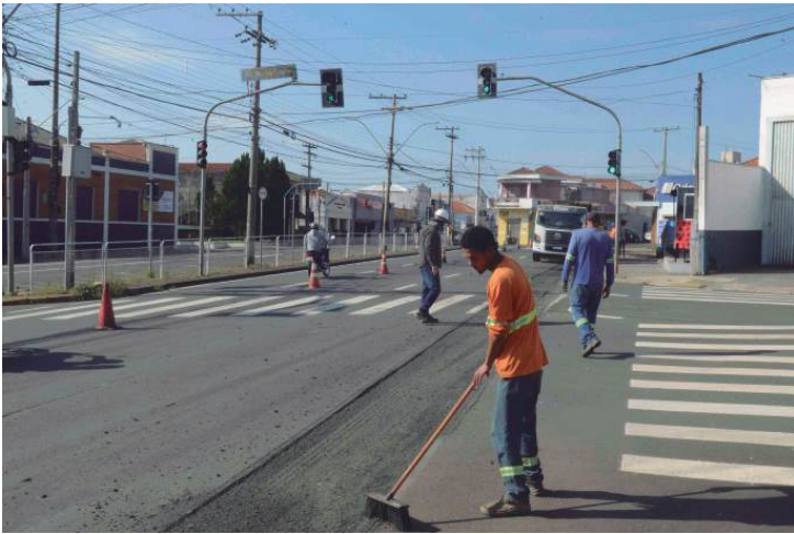
Na avenida Dona Francisca, as equipes realizam os serviços de fresagem
