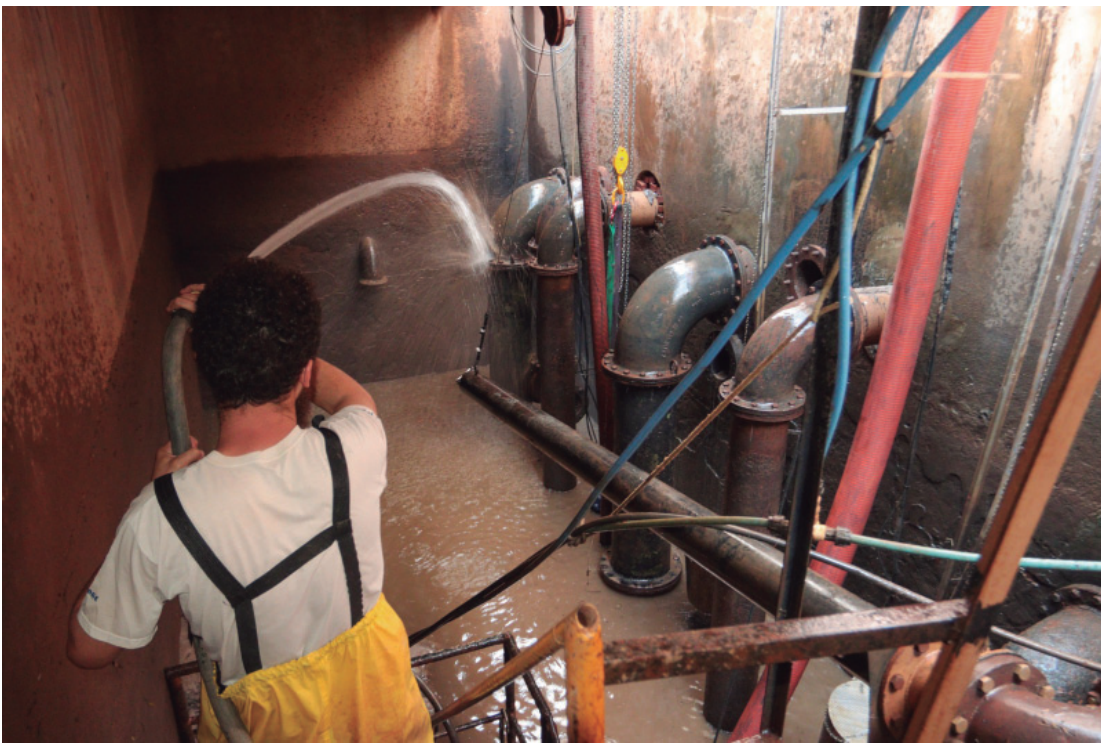
Equipes trabalham na limpeza da Estação de captação do Semae
