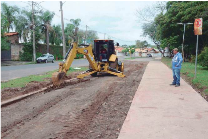
Trecho final da avenida Cruzeiro do Sul é preparado para receber piso intertravado
