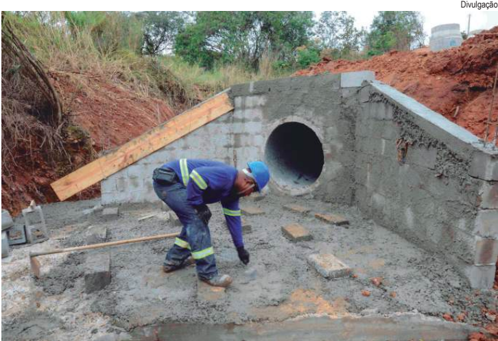
Dissipadores de energia sendo implantados no muro de ala
