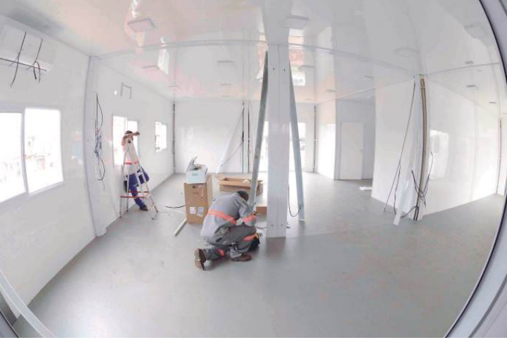
Nova estrutura da Unidade de saúde do Bosques do Lenheiro tem 650 metros quadrados
