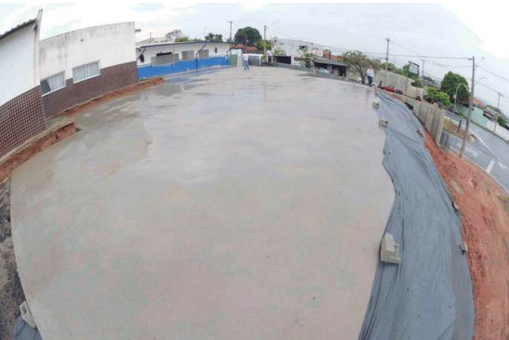
Estrutura na Unidade do Parque Piracicaba está pronta para receber os módulos
