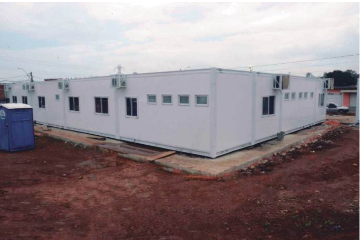
Construído pelo sistema modular tem o tempo da obra como uma das principais vantagens
