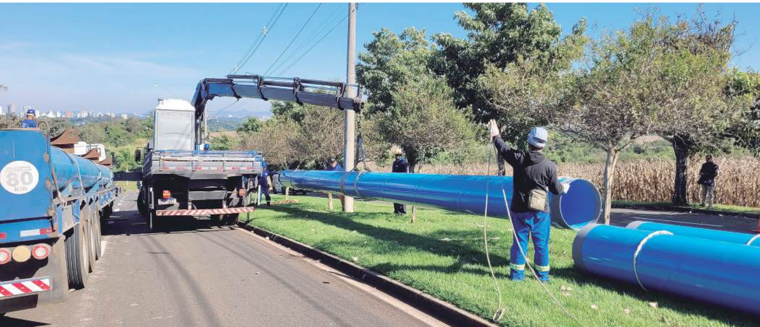
Na semana passada foram descarregados uma nova carga de tubulação que será instalado na região do Santa Rosa
