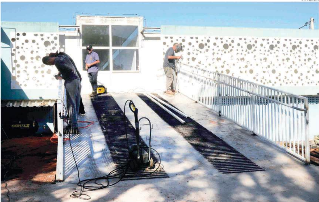
A nova estrutura terá capacidade prevista de 40 leitos e fortalecerá a retaguarda hospitalar da rede municipal
