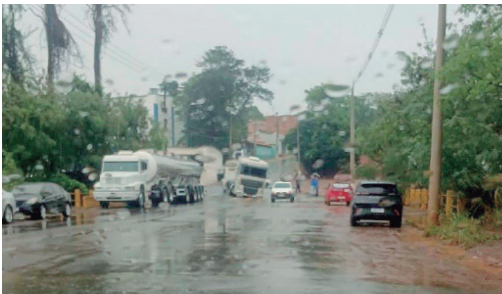
Trecho afetado passa por obras de implantação de emissários para a rede de esgoto
