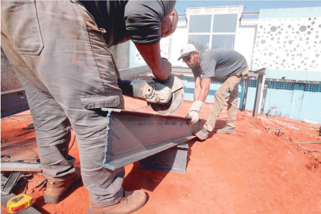
Obras em andamento vão garantir entrada independente para nova unidade de saúde do município
