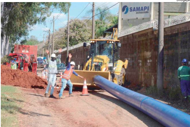
Adutora terá um total de 4,2 quilômetros de tubulação de 500 milímetros em polietileno de alta densidade
