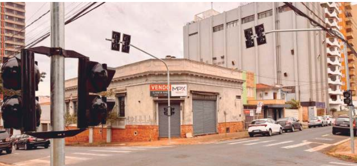
O equipamento foi instalado com o objetivo de organizar o fluxo de veículos e ampliar a segurança no cruzamento
