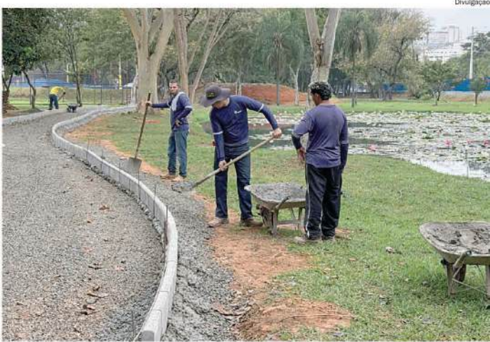
Equipes trabalham no assentamento das chamadas miniguias, para em seguida realizar a instalação do piso intertravado
