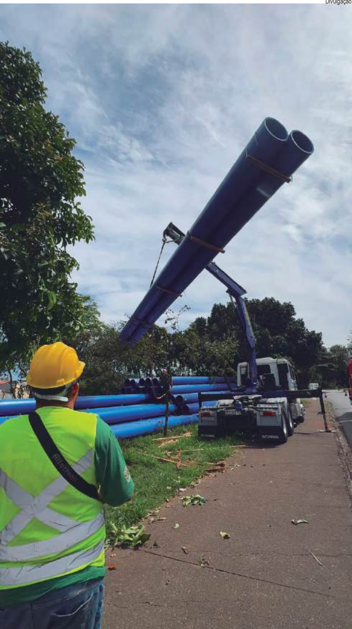
Caminhão munk auxilia a descarregar a tubulação dos caminhões na região do Cecap
