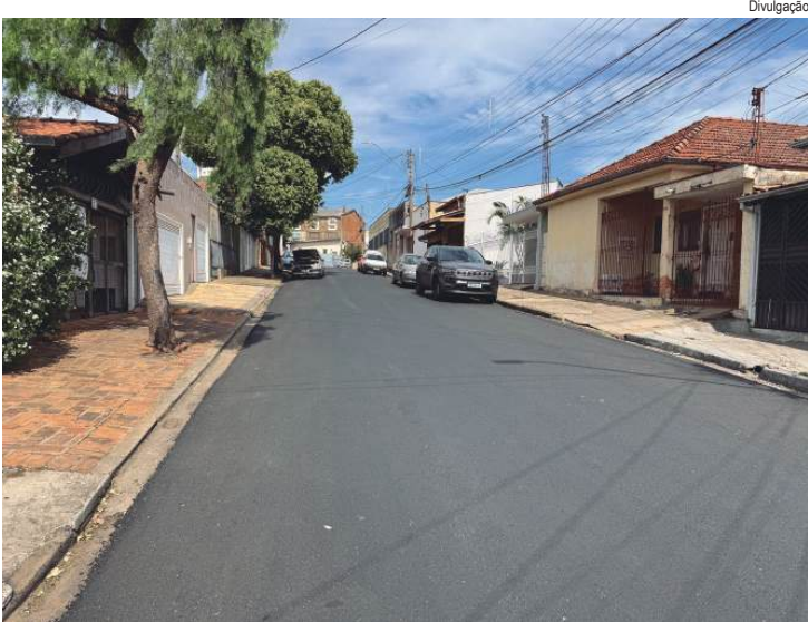
Na rua Minas Gerais, na região da Pauliceia, o recapeamento foi concluído
