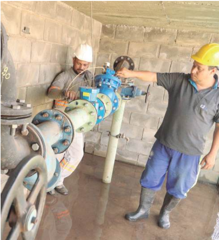
Nesta semana, a Válvula Reguladora de Pressão localizada na região do Aeroporto Municipal recebeu manutenção preventiva
