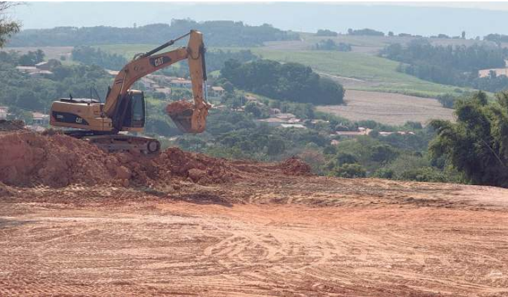
A construção da EMEIF Santana segue com os trabalhos de terraplanagem
