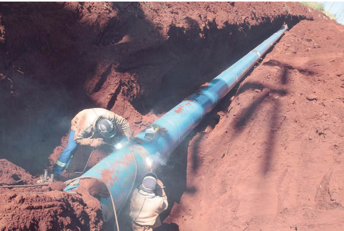
Equipes fazem a soldagem da tubulação da nova rede Torre de TV - Unileste
