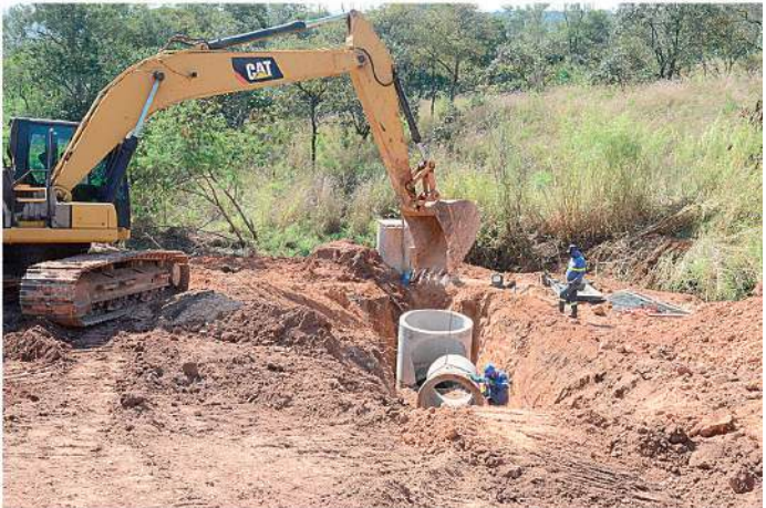
Equipe durante processo de implantação de novas galerias de águas pluviais
