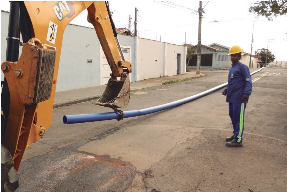
Cerca de 100 metros de novas tubulações foram instaladas na rua Luiz Claudio, região de Santa Teresinha
