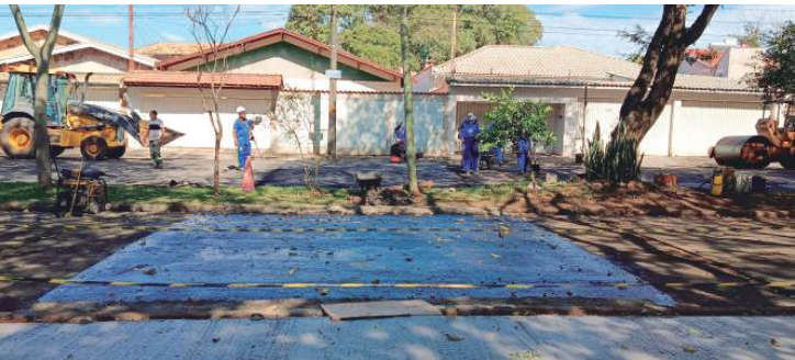
Faixas elevadas de travessia conectam a calçada à ciclovia local, garantindo segurança e acessibilidade
