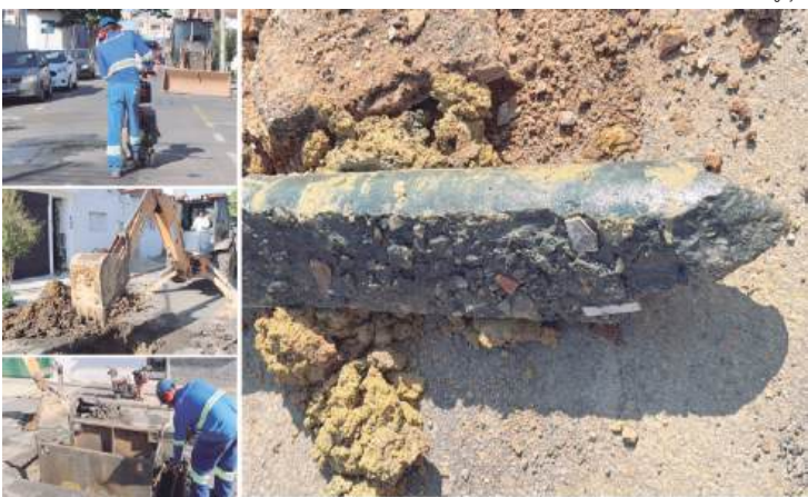
Intervenção restabeleceu a plena capacidade da rede após bloqueio provocado pelo descarte irregular
