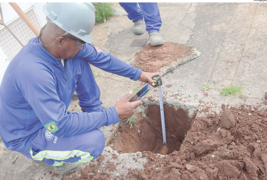
Equipes também executam serviços preliminares de sondagem e plano de furo, fundamentais para garantir precisão e segurança na execução
