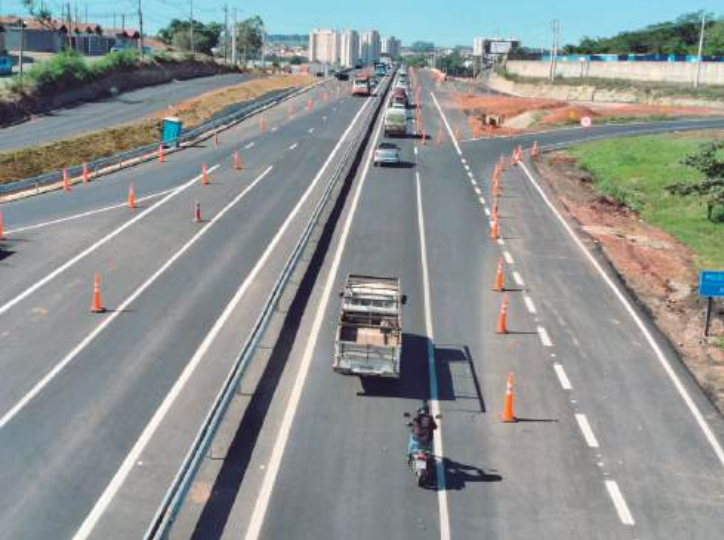
Intervenções na SP-304 foram executadas com financiamento do BNDES e já melhoram a circulação dos veículos
