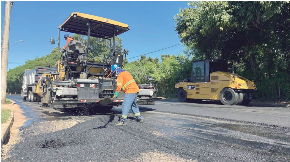
Na área da mobilidade urbana e da infraestrutura, a Prefeitura executou o recapeamento de 128 quilômetros de vias, abrangendo 106 ruas e avenidas
