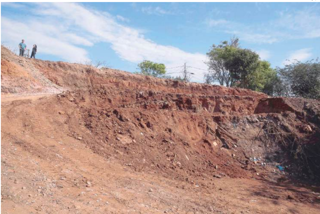
Vereador Pedro Kawai acompanha há oito anos a situação e espera ver o local ser transformado em praça para a comunidade
