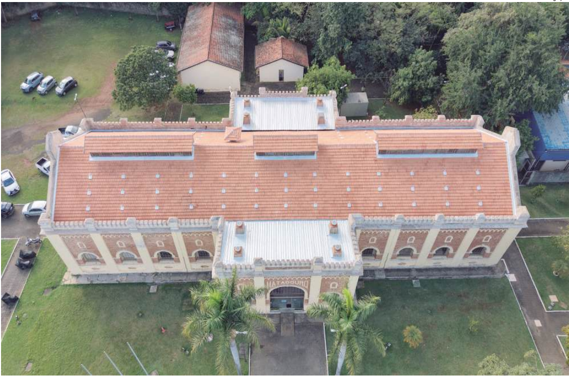
Obra substituiu toda a cobertura, com troca do madeiramento, ripas e telhas, além da instalação de manta térmica; intervenção foi aprovada
