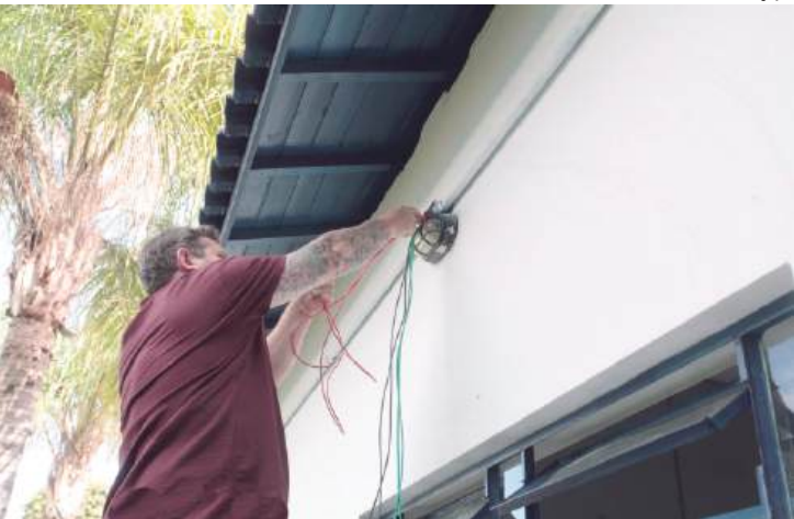
O CRAS Novo Horizonte começou a receber reparos na parte elétrica
