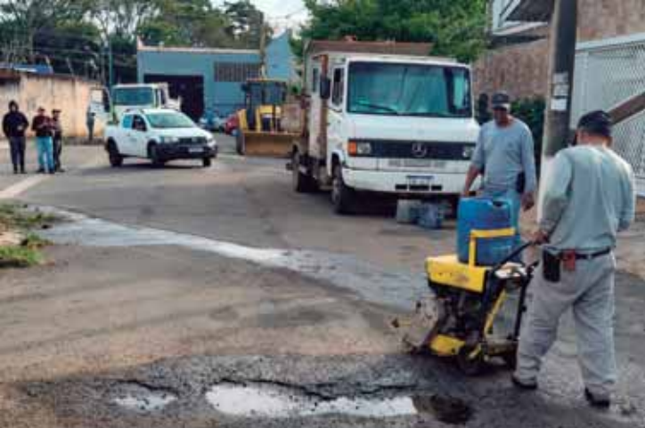
Pedro Kawai (PSDB) solicitou recapeamento e instalação de boca de lobo na rua Marco Antônio Corrêa Altafin
