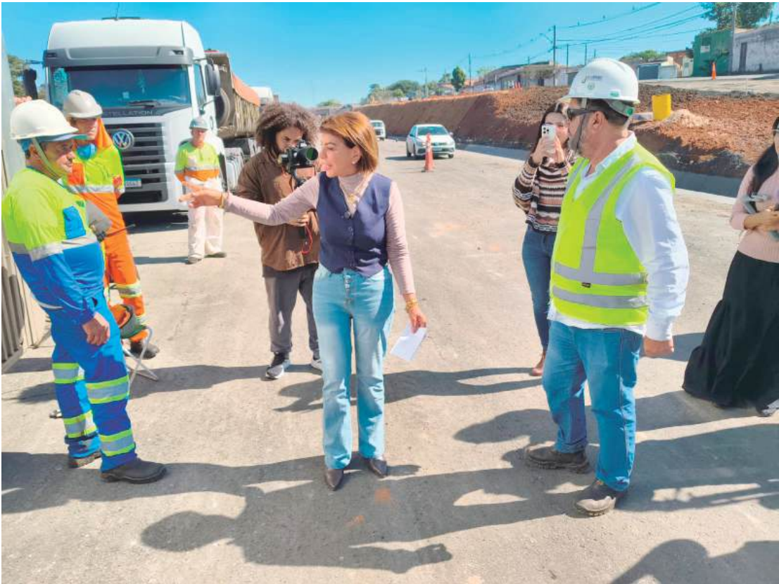
A deputada Professora Bebel, que no último dia 18 esteve vistoriando as obras e conversou com trabalhadores
