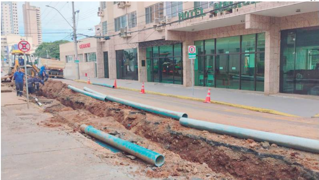
Servidores do Sema realizam troca de rede de água na região central da cidade
