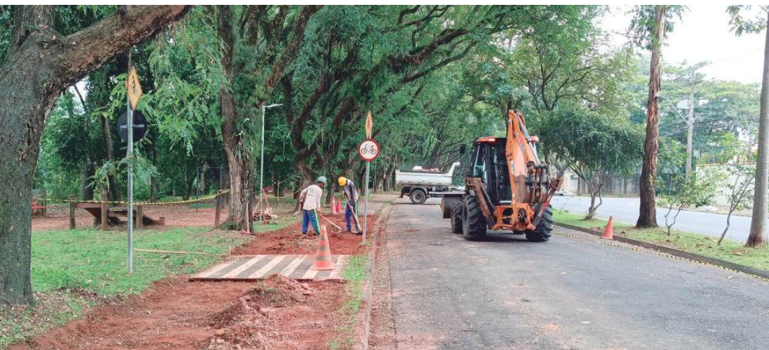
Equipe durante obras de requalificação da ciclovia da avenida Cruzeiro do Sul
