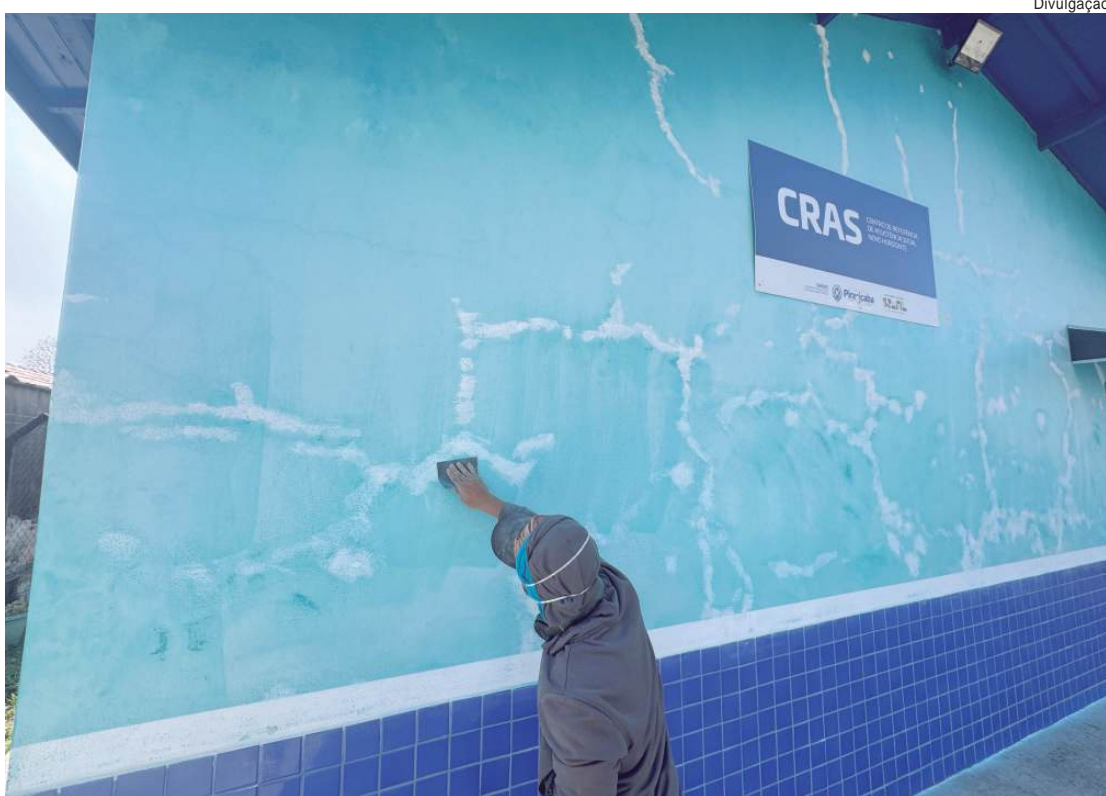
As equipes estão trabalhando no preparo das paredes
