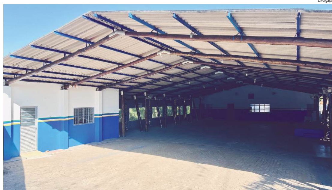
No Centro Social Santana, as intervenções incluíram a revisão das instalações elétricas e manutenção das coberturas
