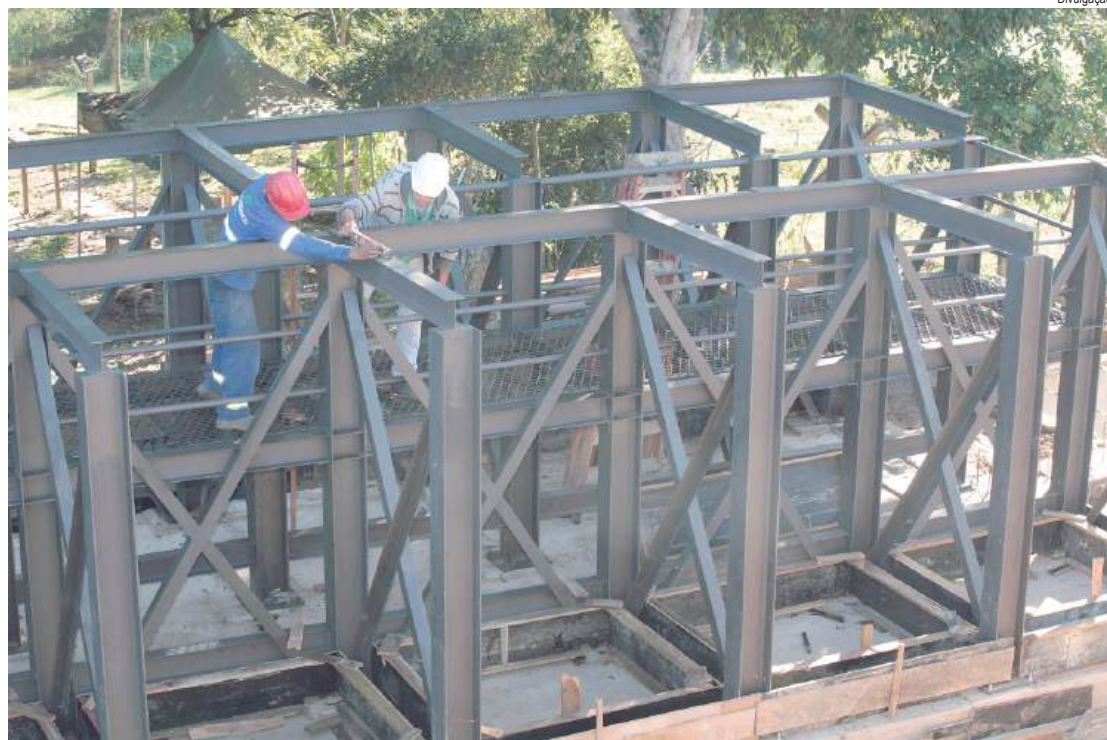
Obras para estruturação do pórtico que será instalado para movimentação de bags de lodo dentro da ETL.
