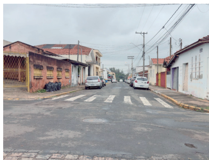
Durante a execução dos serviços, o fluxo de veículos será mantido, sem necessidade de interrupção total do trânsito
