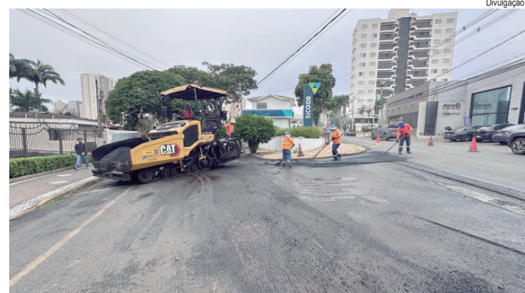
Avenida Brasil, no Jardim Europa, começa a receber nova pavimentação asfáltica
