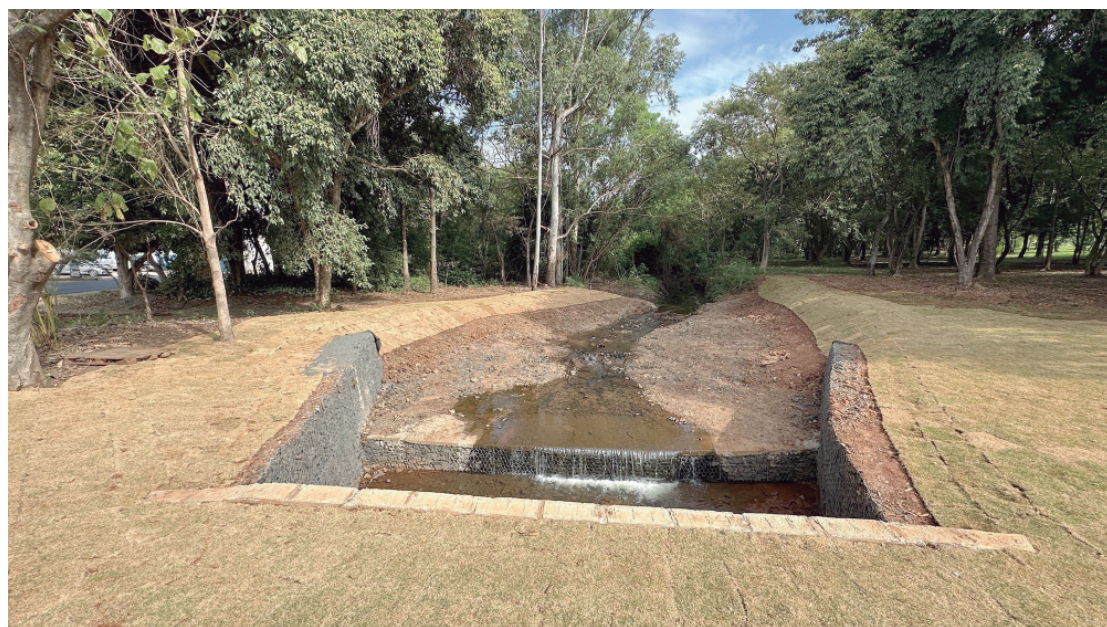
Foram implantados gabiões nas duas margens do córrego
