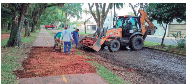
Imagem da equipe durante a retirada de concreto danificado da pista
