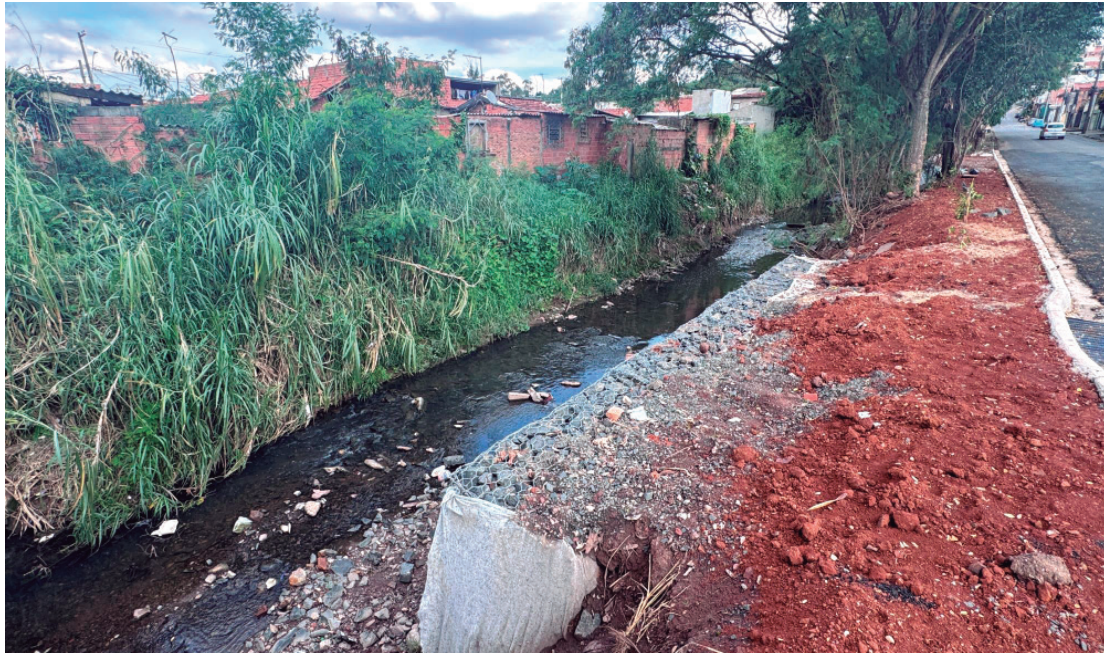
Muro de gabião evita o avanço da erosão às margens do córrego do Enxofre
