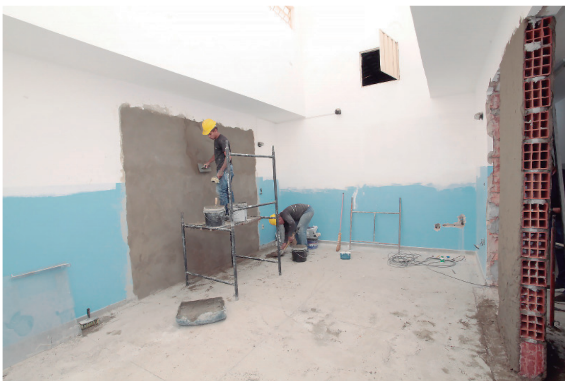
Obras na UBS Vila Sônia, uma das unidades da região Norte
