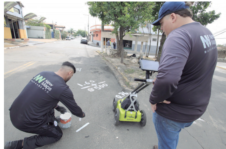
Em Santa Teresinha, os logradouros próximos a Rua Ricardo Melotto receberão as primeiras intervenções da obra
